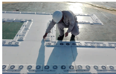
技术人员现场测量 Technical Staff On-site Commissioning
